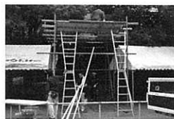
〈単管組立て班〉
